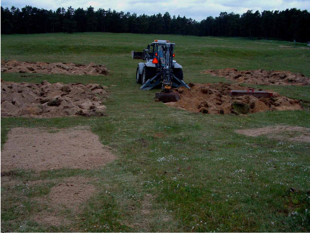
Åtgärder på Rinkaby skjutfält. Närmast i bild syns kalkade områden i slänten. Längre bort syns kalkning i kombination med omrörning.
