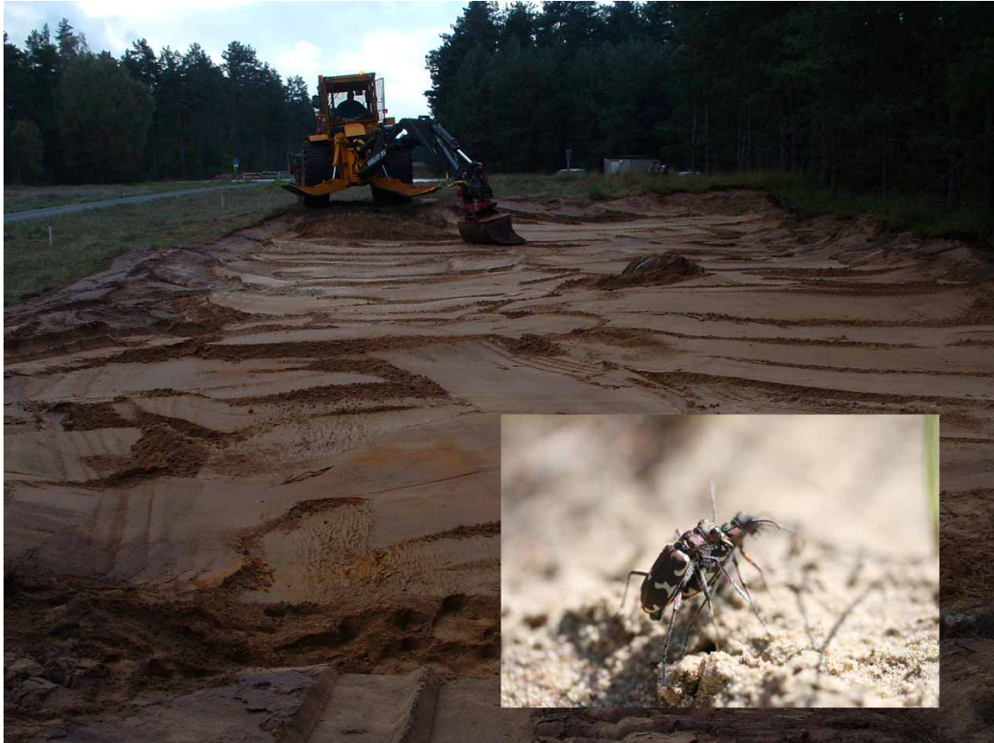
Schaktning av ytjord vid Everöds järnvägsbank. Infälld bild visar brun sandjägare i åtgärdad yta ett par år senare.
